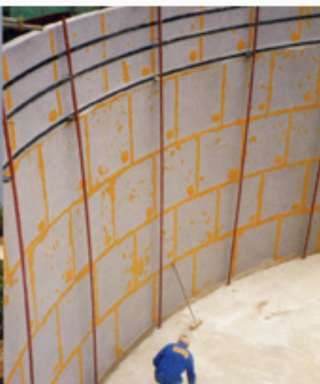
[Vue intérieure] Renfort carbone de la face interne
